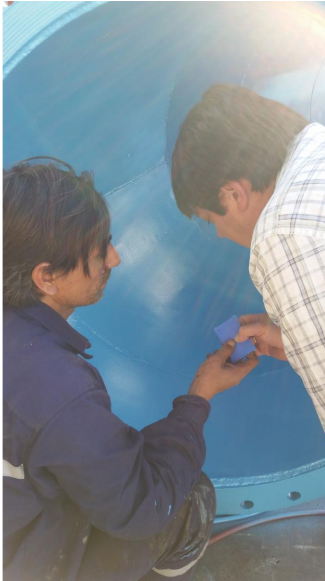
Control de espesores
